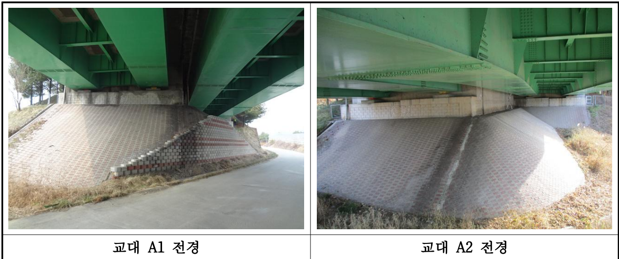
【사진 3.33】 교대 전경
