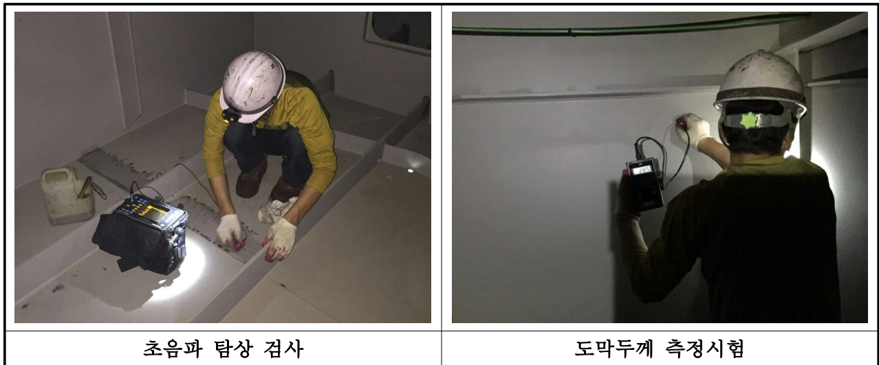
【사진 3.50】 강재 내구성조사 전경
