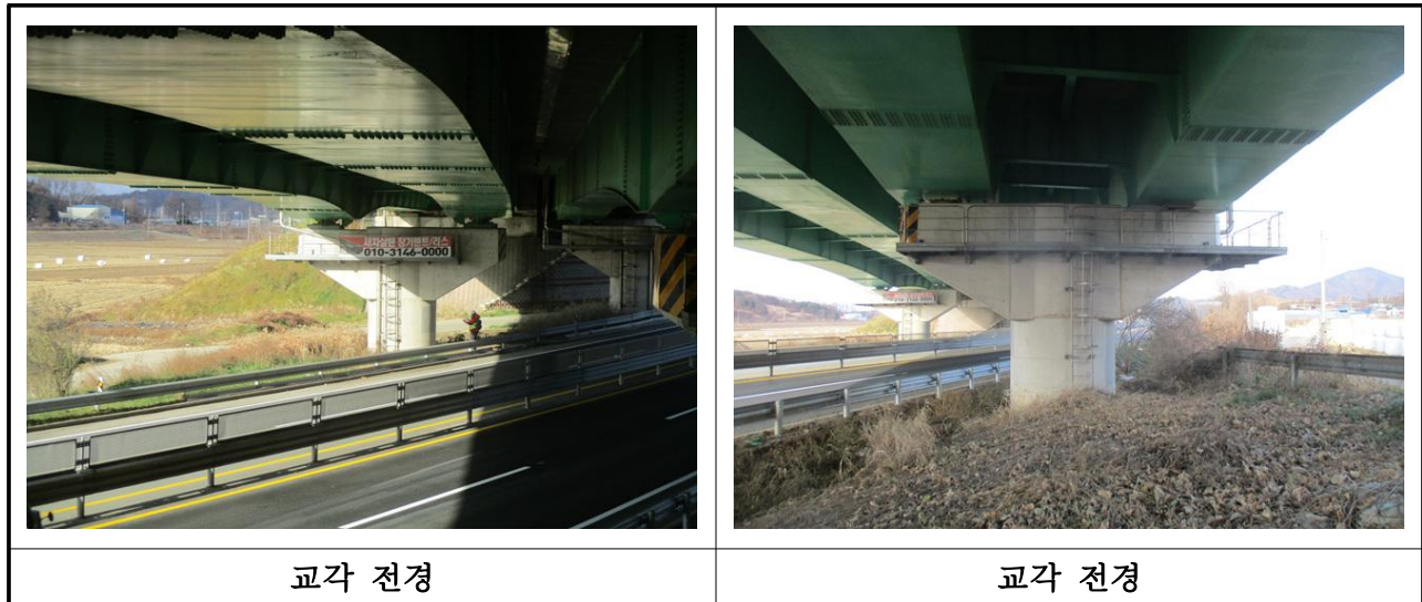
【사진 3.11】 교각 전경
