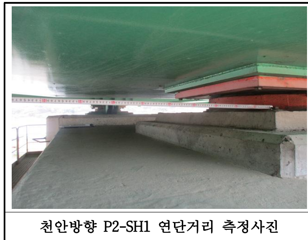
【사진 3.15】 연단거리 측정
