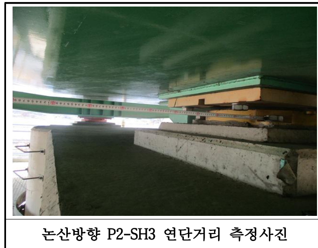
【사진 3.38】 연단거리 측정
