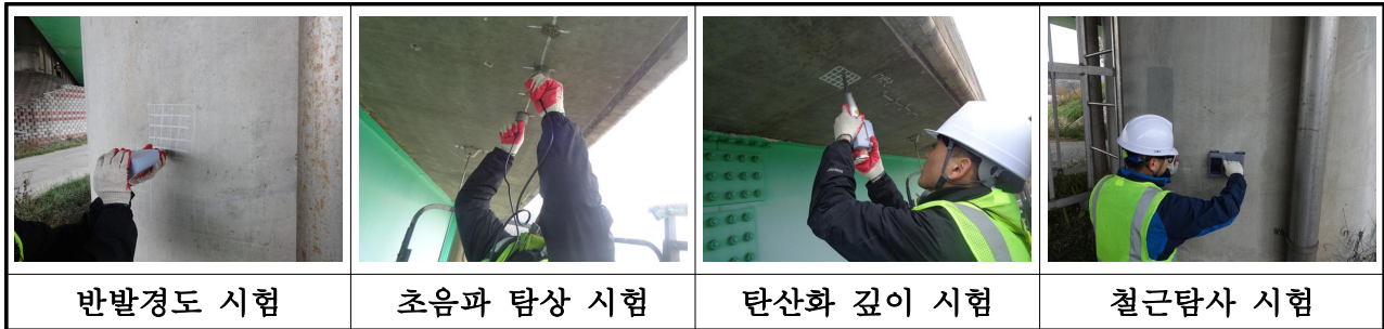
【사진 3.49】 콘크리트 내구성조사 전경
