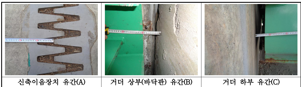
【사진 3.19】 신축이음 유간 측정방법
