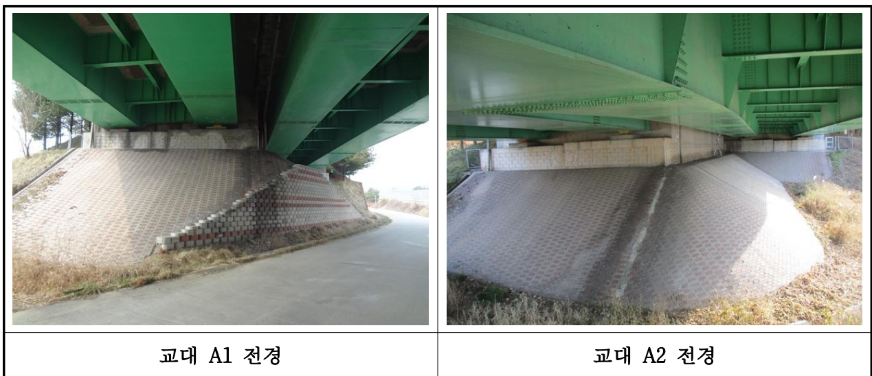
【사진 3.9】 교대 전경
