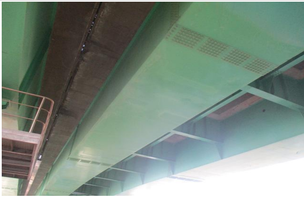
바닥판하면 및 거더 외부 전경
