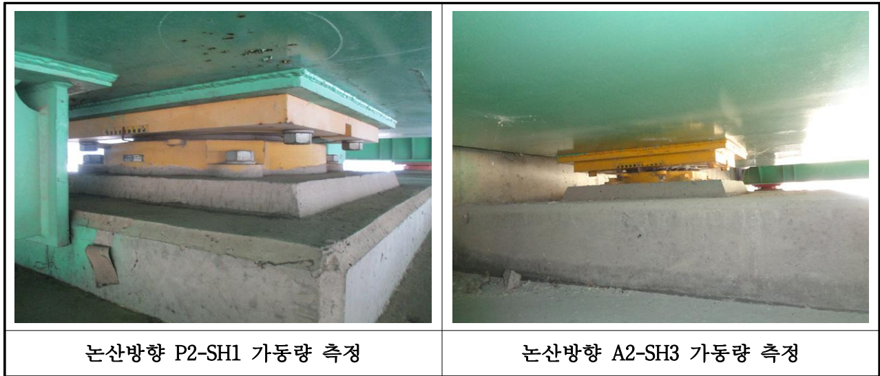
【사진 3.39】교량받침 가동량 측정 전경
