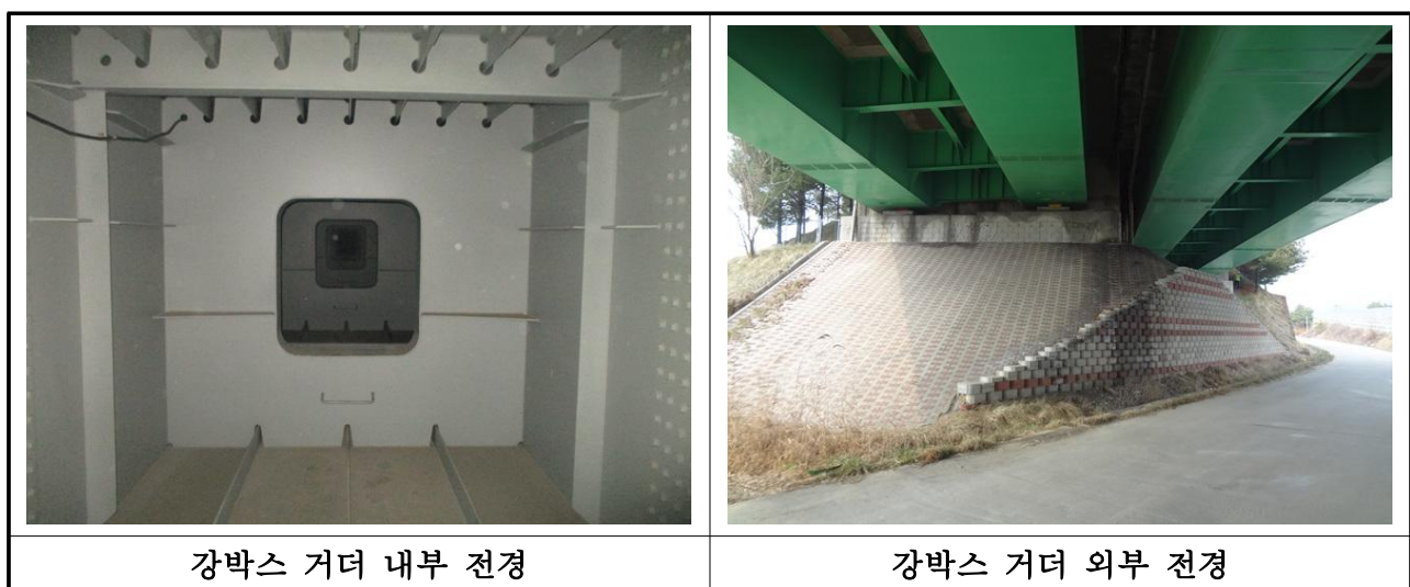
【사진 3.4】 강박스 거더 전경
